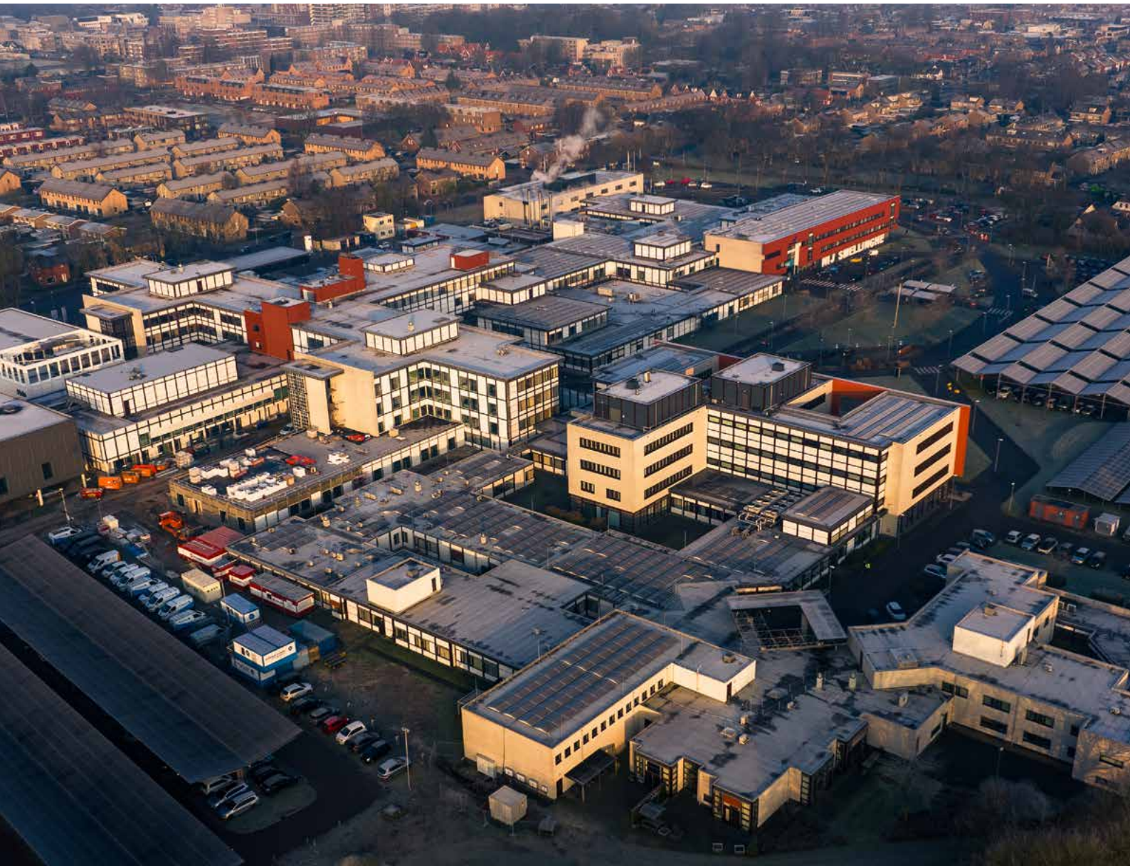
Afdeling Acute Zorg met Spoedplein in aanbouw
